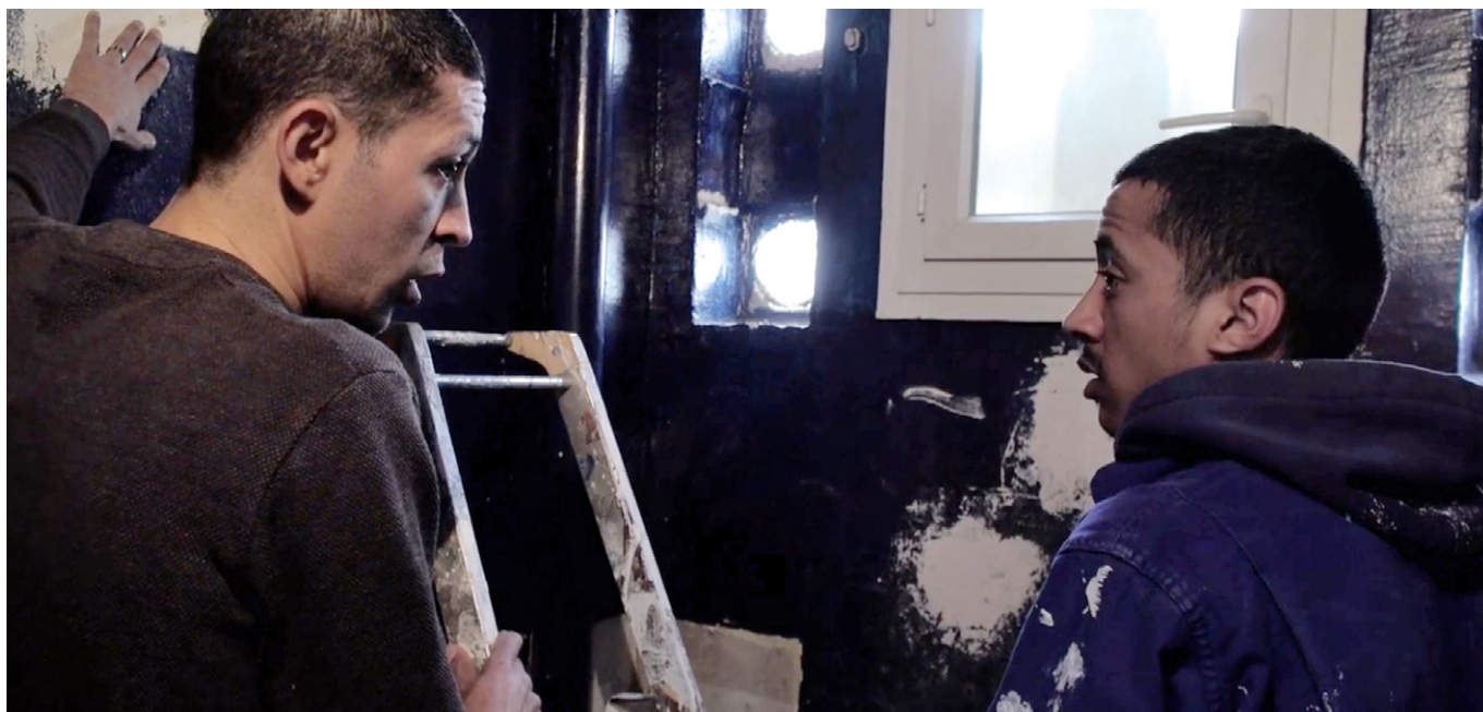
Farid Klai, éducateur technique, et un apprenti sur le chantier de rénovation et d'adaptation de la salle de bains de Propolis Mendgi.
