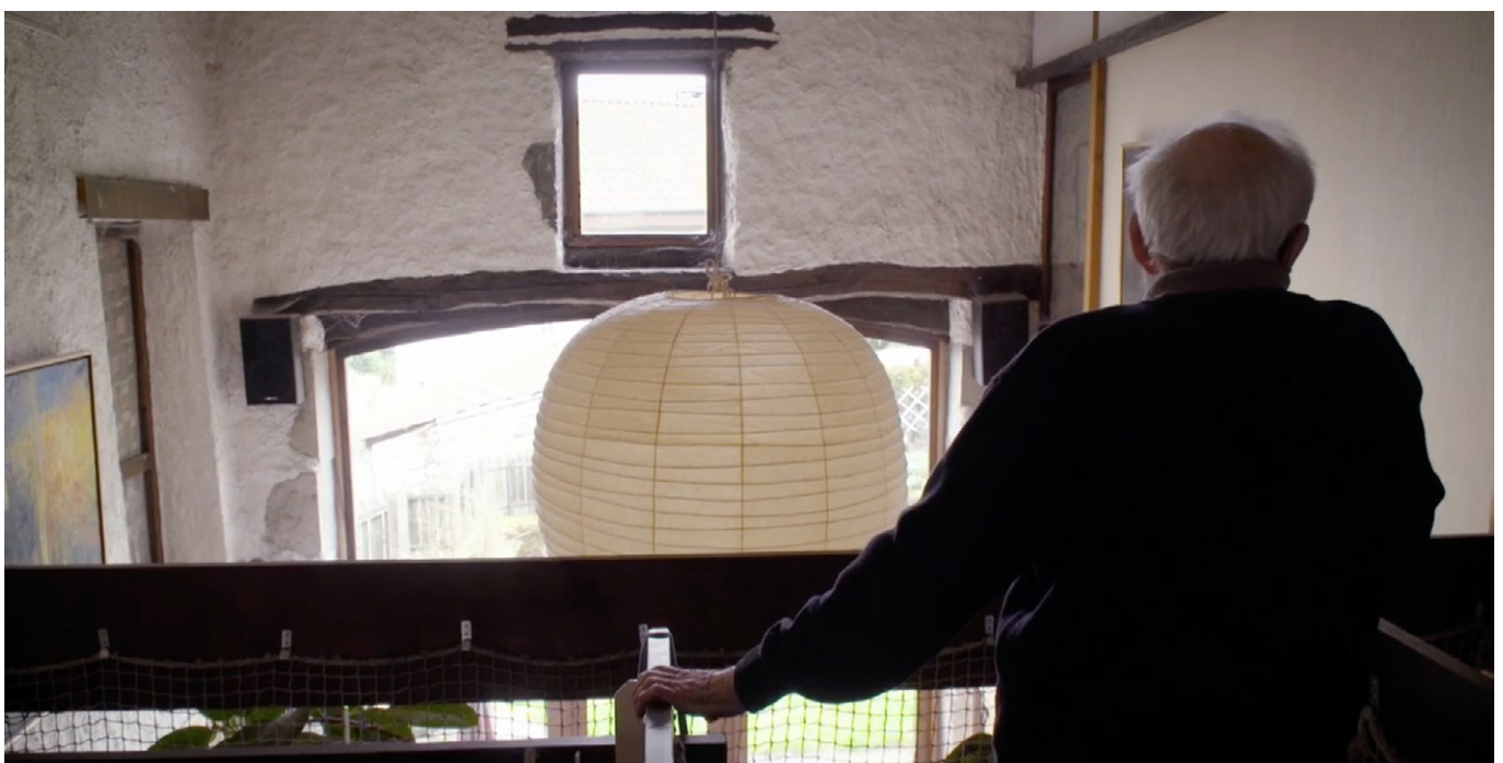
Henri W. accoudé au garde-corps de la mezzanine qu'il a créée. On distingue les filets installés pour prévenir les chutes.
