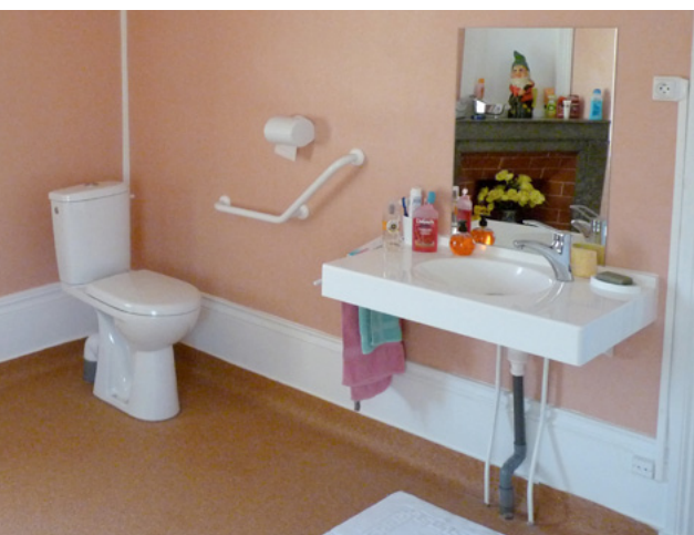
Aménagement de salle de bains adaptée pour une personne âgée. Voir encadré en page 4.
